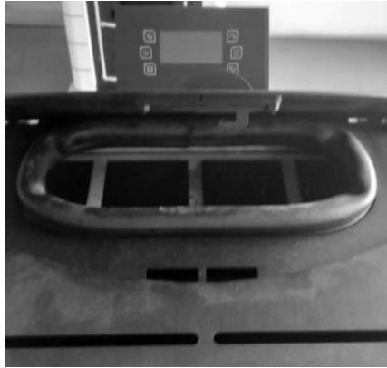
Figura 26 - Reabastecimento do depósito de pellets
