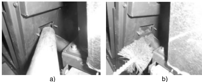
Figura 87 - a) Aspirare l'interno; b) Pulizia con uno spazzolino
