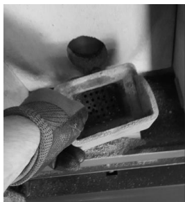
a) Remoção queimador
