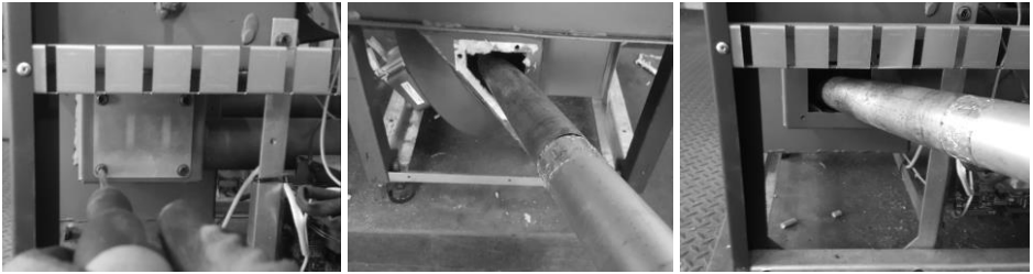
a) Remoção tampa lateral
