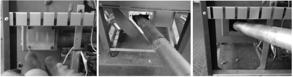
a) Remoção tampa lateral
